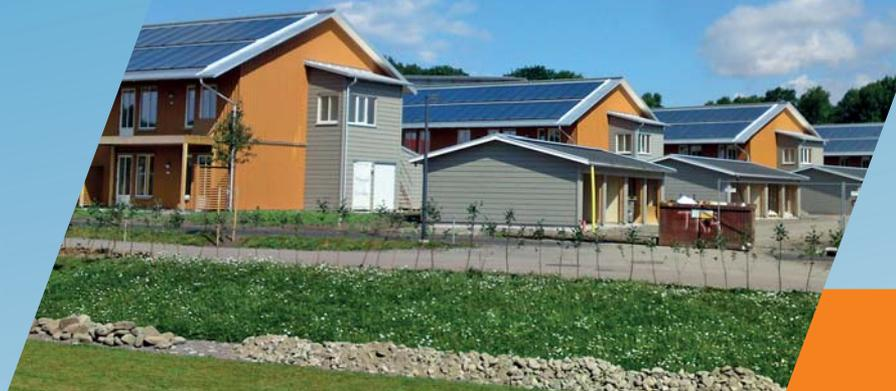
Quest'area residenziale inaugurata nel 2013 è alimentata da un sistema di teleriscaldamento che combina biomassa e 680 m<sup>2</sup> di collettori solari termici integrati nel tetto. Tutti gli edifici rispondono a standard energetici molto elevati e presentano un basso fabbisogno termico. Il sistema di distribuzione centralizzato, tuttavia, si dimostra efficace, consentendo anche un impiego efficiente delle energie rinnovabili.
