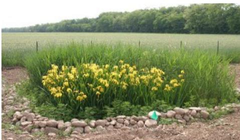
Figura 9: Sistemi di fitodepurazione a servizio di una civile abitazione (10 AE)
