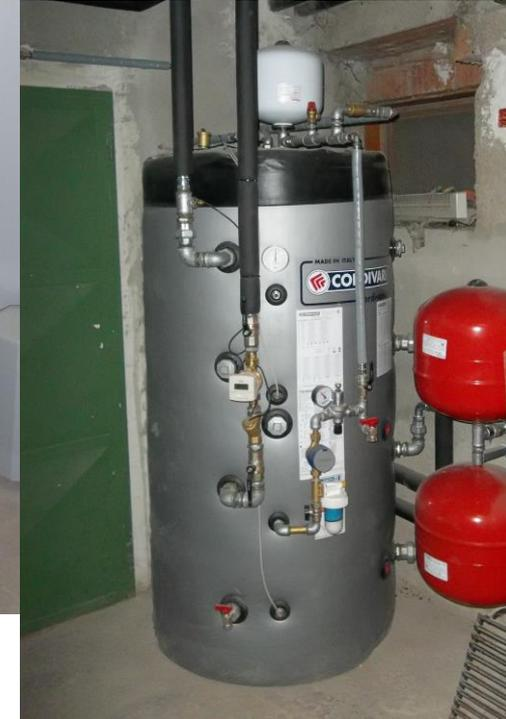
Potenza installata : 34 kW<sub>t</sub> a pellet con deposito a caricamento pneumatico
